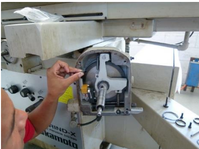
平面研削盤切込用爪の交換。故障箇所は彼らが確認し，部品は日本から持参した。
