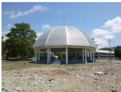
工学部内。壊れた校舎は全て撤去され、新校舎の建設を待つ。
