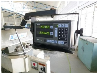
カウンタも取替え完了。 動作確認終了。
