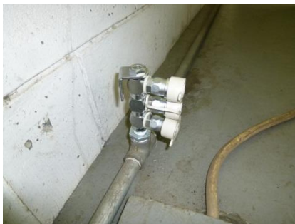
工場内エア配管の整備を行い、エアカプラ3個口の立ち上がりを3か所新たに設置した
