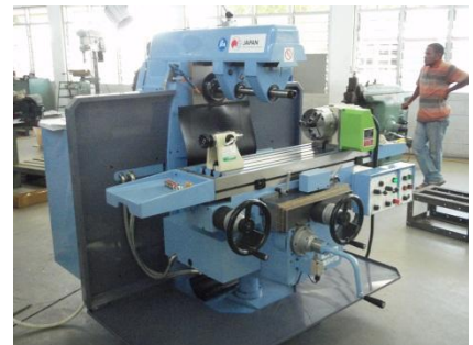
各部品・機器を取り付け、横フライス盤の据え付け完了
