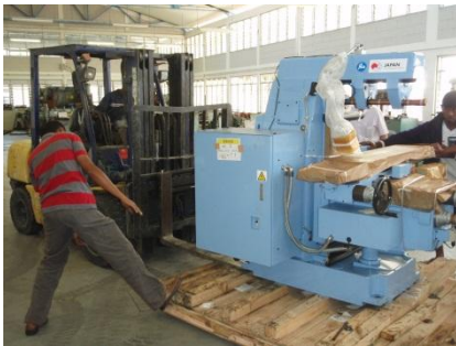
横フライス盤の据え付けの様子 現地の業者に移動を依頼した
