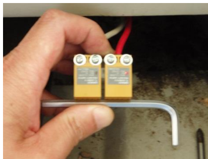
平面研削盤テーブルの近接スイッ チ左側が作動しておらず配線が切 断されていたため繋ぎこみ、修復し た
