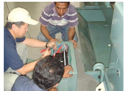
電圧380Vをトランスを介し、220Vに変圧し、電源を繋ぎ込む
